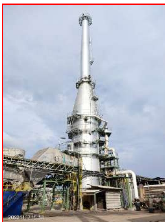
ภาพที่ 2.2-2 Wet Scrubber และ dry Scrubber
