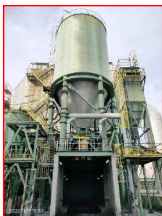
ภาพที่ 2.2-29 ไซโลเก็บถ้ำเบาแบบปิด
