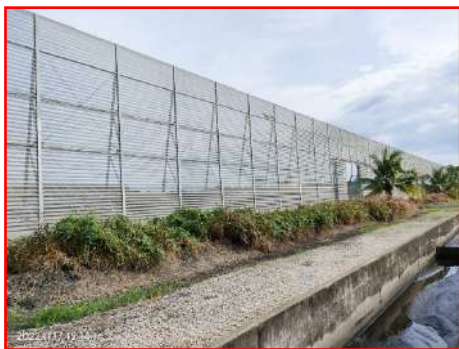
ภาพที่ 2.2-5 ผนังชะลอลมล้อมรอบพื้นที่กองเก็บถ่าน หินกลางแจ้ง
