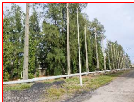
ภาพที่ 2.2-6 ม่านน้ำทางทิศเหนือของลานกองถ่าน หินด้านที่ติดกับโรงงานอื่น
