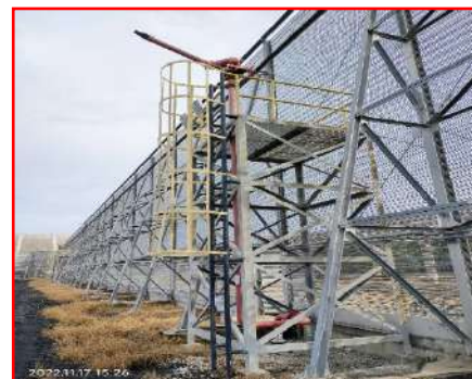
ภาพที่ 2.2-4 การฉีดพรมน้ำบริเวณพื้นที่กองเก็บ เชื้อเพลิงถ่านหิน
