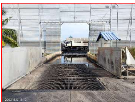
ภาพที่ 2.2-9 พื้นที่ล้างล้อรถบรรทุกก่อนออกจากพื้นที่ ลานกองเก็บถ่านหินกลางแจ้ง
