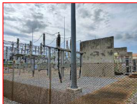
ภาพที่ 2.2-41 Fire Wall บริเวณ Transformer และ อุปกรณ์ป้องกันฟ้าผ่า
