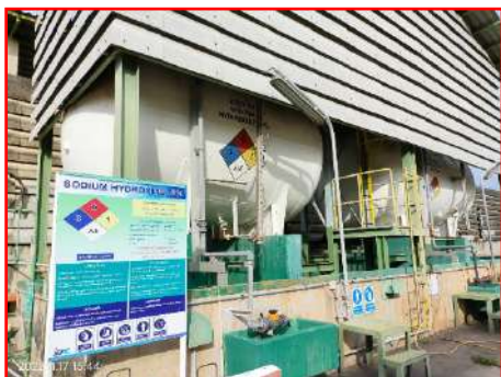
ภาพที่ 2.2-13 Dike สำหรับถังเก็บสารเคมีและถังสำรองเชื้อเพลิง
