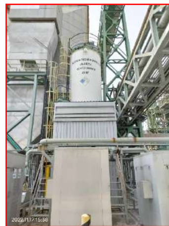
ภาพที่ 2.2-2 Wet Scrubber และ dry Scrubber
