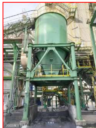
ภาพที่ 2.2-28 ไซโลหรือ Collecting Pit เก็บถ้ำหนัก แบบปิด
